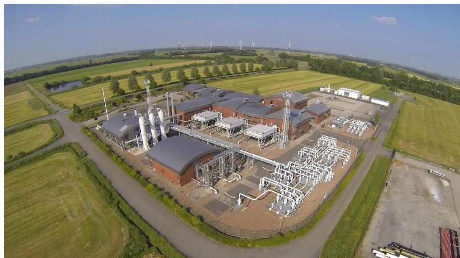
Der EWE-Gasspeicher in Elsfleth-Huntorf. Hier wird eine Gaskaverne auf Wasserstoff umgerüstet. Foto: EWE
