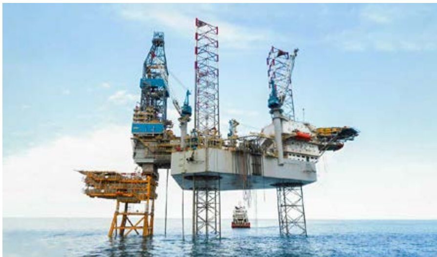
< Vega Pléyade ist über eine 77 km lange Gasexport-Pipeline mit der Aufbereitungsanlage an Land verbunden.
