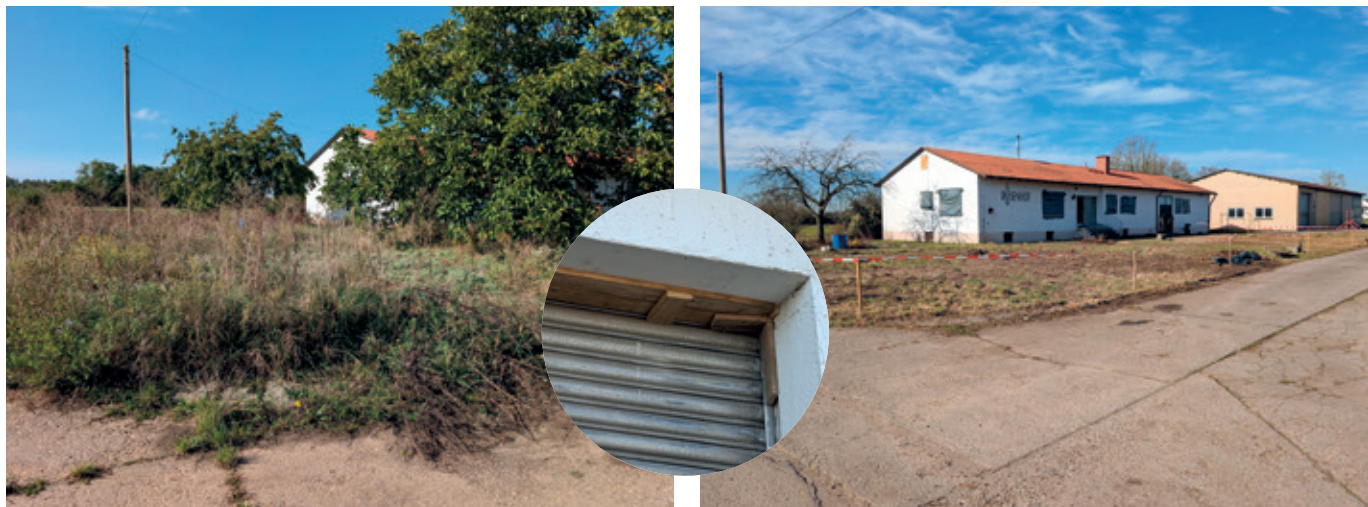
Links: Rosenhof vor den Baumfällungen, Mitte: Gebäudeverschluss trotz bekannter Fledermausquartiere, rechts: Rosenhof nach den Baumfällungen
