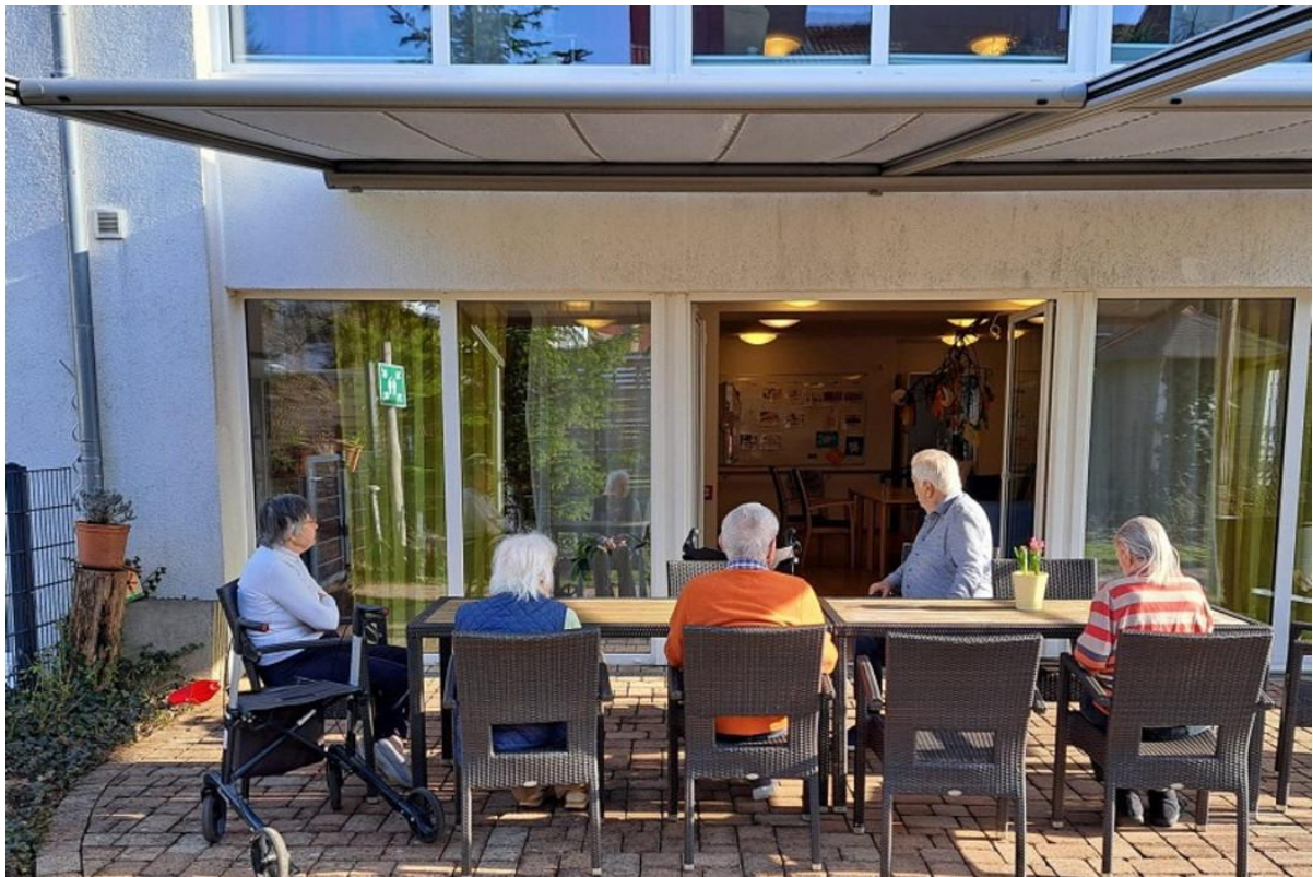
Witterungsbeständige Pergola-Markise einer Senioren-Wohngruppe des DRK KV Bielefeld
