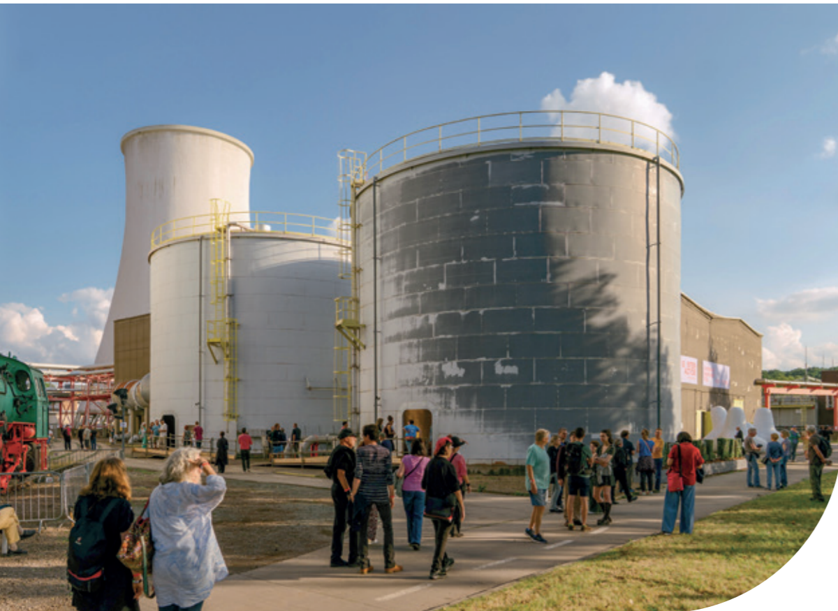
Diese zwei Behälter und der im Hintergrund sichtbare Kühlturm waren Teil der Ausstellungsflächen.
