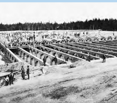
Bau des Hochbehälters Deisenhofen 1883, als einer von drei Sammelbehältern der Münchner Wasserversorgung
