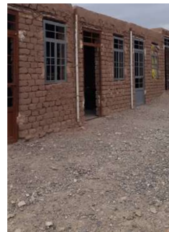
Blick auf das Gebäude der Schule für Menschen mit Blindheit und Sehbehinderung in der Nähe von Herat (links) und in eines der Klassenzimmer (rechts).
