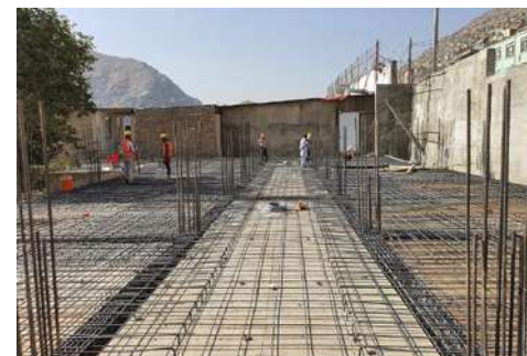
Der Bau des zweiten Stockwerks der Mohammad Parsa Grundschule steht kurz vor der Winterpause.
