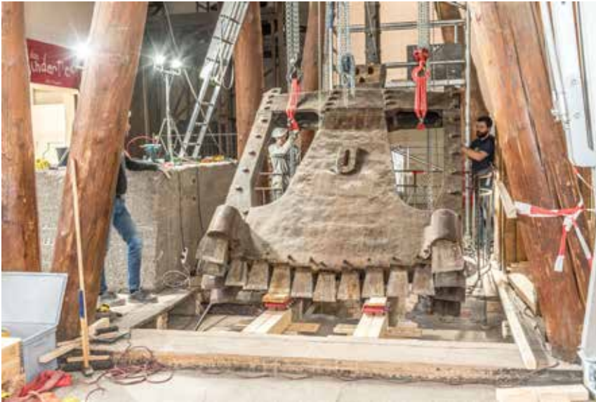
Abbau des Kind-Chaudron-Schachtbohrers (12 t) durch das Duisburger Restaurierungsatelier Die Schmiede.
