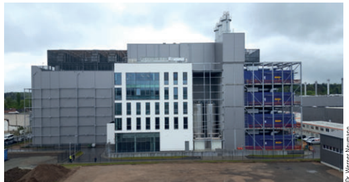
Rechenzentrum Equinix in Seckbach, Notstromdiesel rechts im Bild
