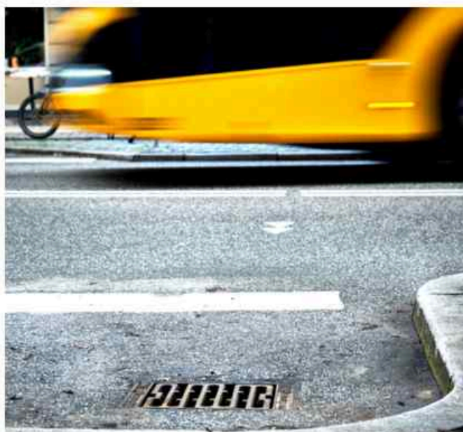
Die Installation des URBANFILTERS in Straßenabläufe in Kopenhagen ist der vierte Praxistest im Realbetrieb seit Beginn der Kooperation der Audi Stiftung für Umwelt mit der TU Berlin.
