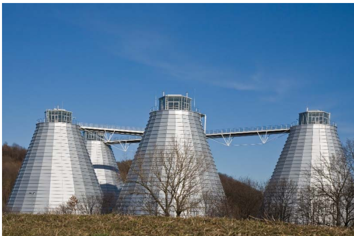
Faultürme für das Klärwerk der Stadtentwässerung München
