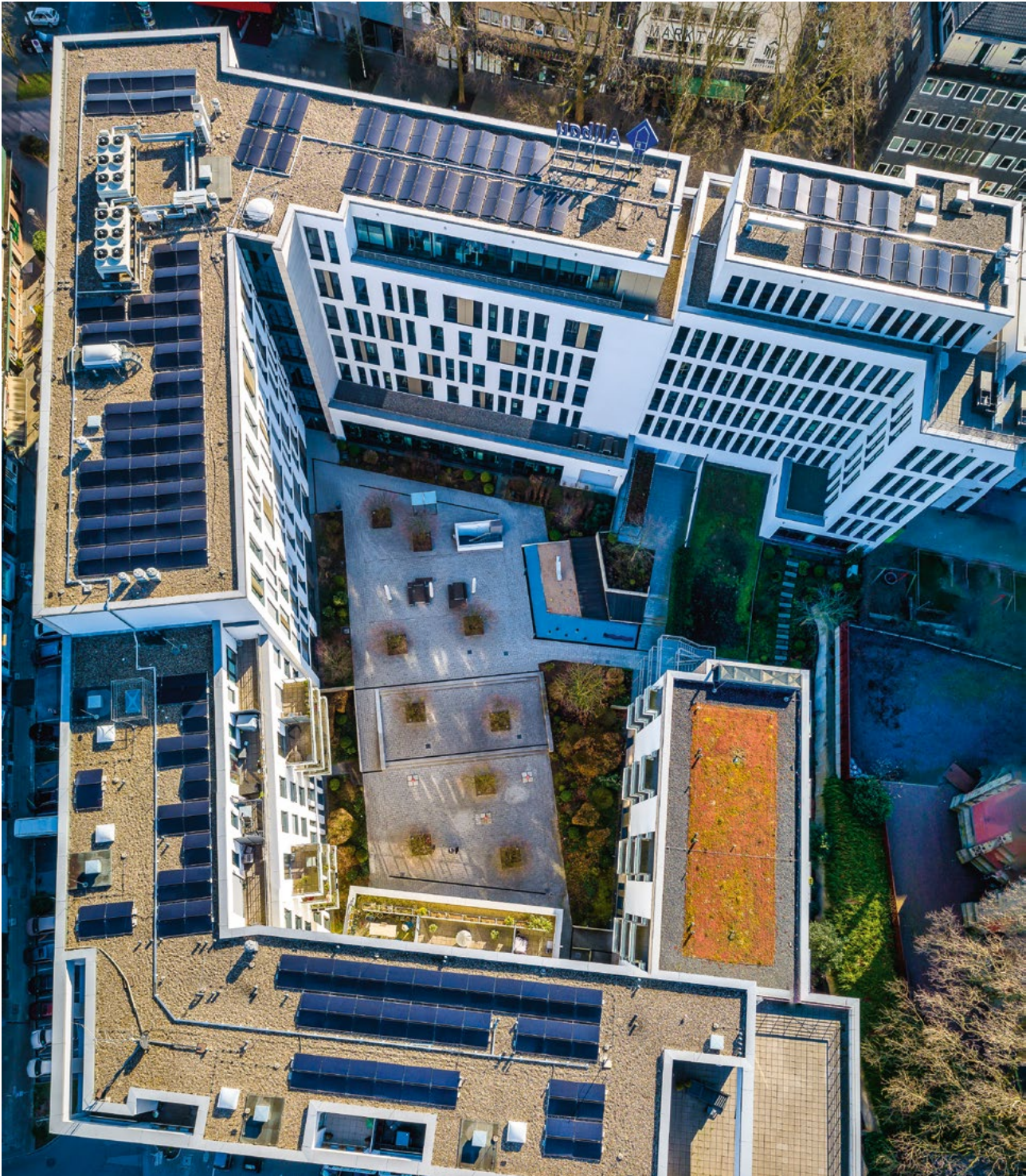
▲ Strombedarf mittels regenerativer Sonnenenergie decken: Die Photovoltaik-Anlage auf dem Dach der Allbau-Hauptverwaltung.
