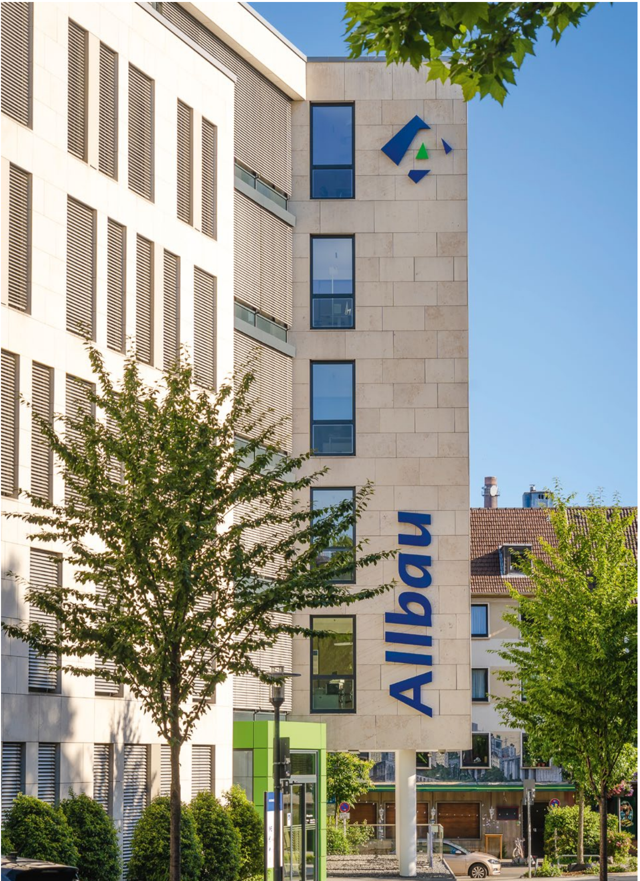
▲ Die Allbau Hauptverwaltung in der Kastanienallee.
