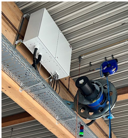
a) Kabeltrommel mit Rückspulfunktion;
