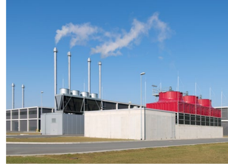
Die Energiezentrale SF3 direkt auf dem Gelände des BER
