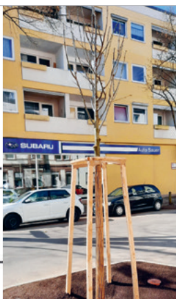
Regenrückhalt in Saarbrücken mittels Baumrigolen.
