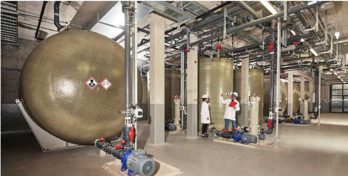
▲ Die unterirdischen Elektrolyt-Tanks des Fraunhofer ICT für die Redox-Flow-Batterie Foto: Fraunhofer ICT
