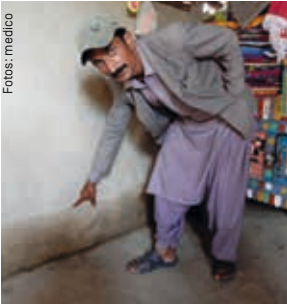
Glück gehabt: In diesem Haus ist das Wasser nicht allzu hoch gestiegen.
