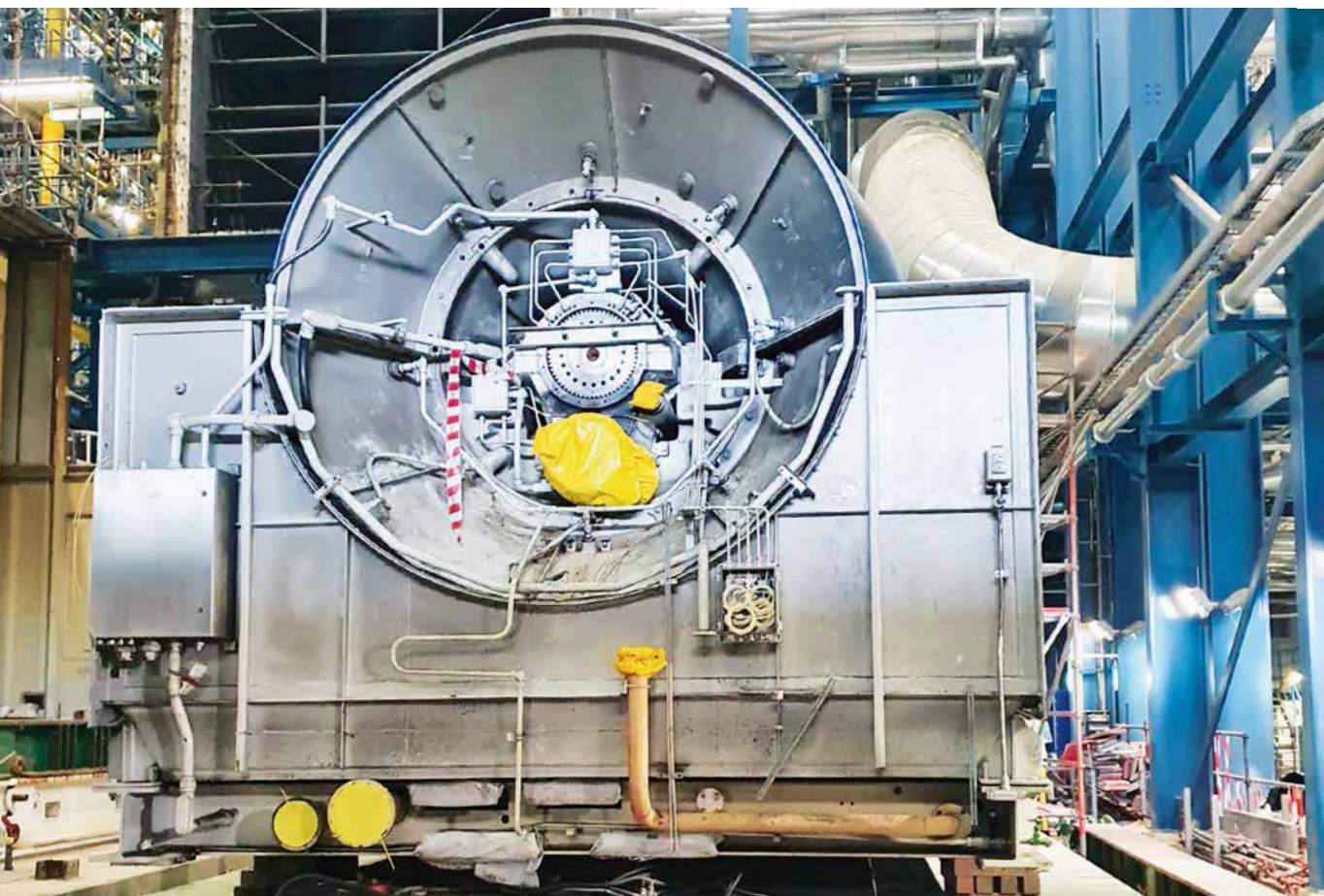
Eine der beiden neuen Gasturbinen der GuD2 beim Einbringen an ihren Standort.
