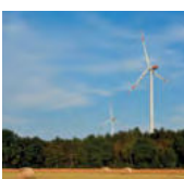
Schwanewede 6,4 MW Leistung, in Betrieb seit 2015
