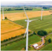
Uetersen 4,4 MW Leistung, in Betrieb seit 2001 (Repowering geplant)
