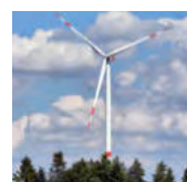
Frickenhofer Höhe II 3,6 MW Leistung, in Betrieb seit 2019
