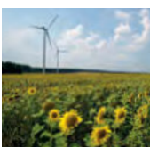
Buchhain II 6 MW Leistung, in Betrieb seit 2012
