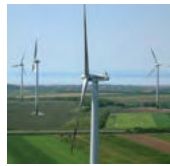
Parndorf (Österreich) 5,7 MW Leistung, in Betrieb seit 2004 (Repowering in Umsetzung)
