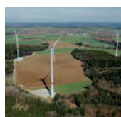
Frickenhofer Höhe 7,2 MW Leistung, in Betrieb seit 2016
