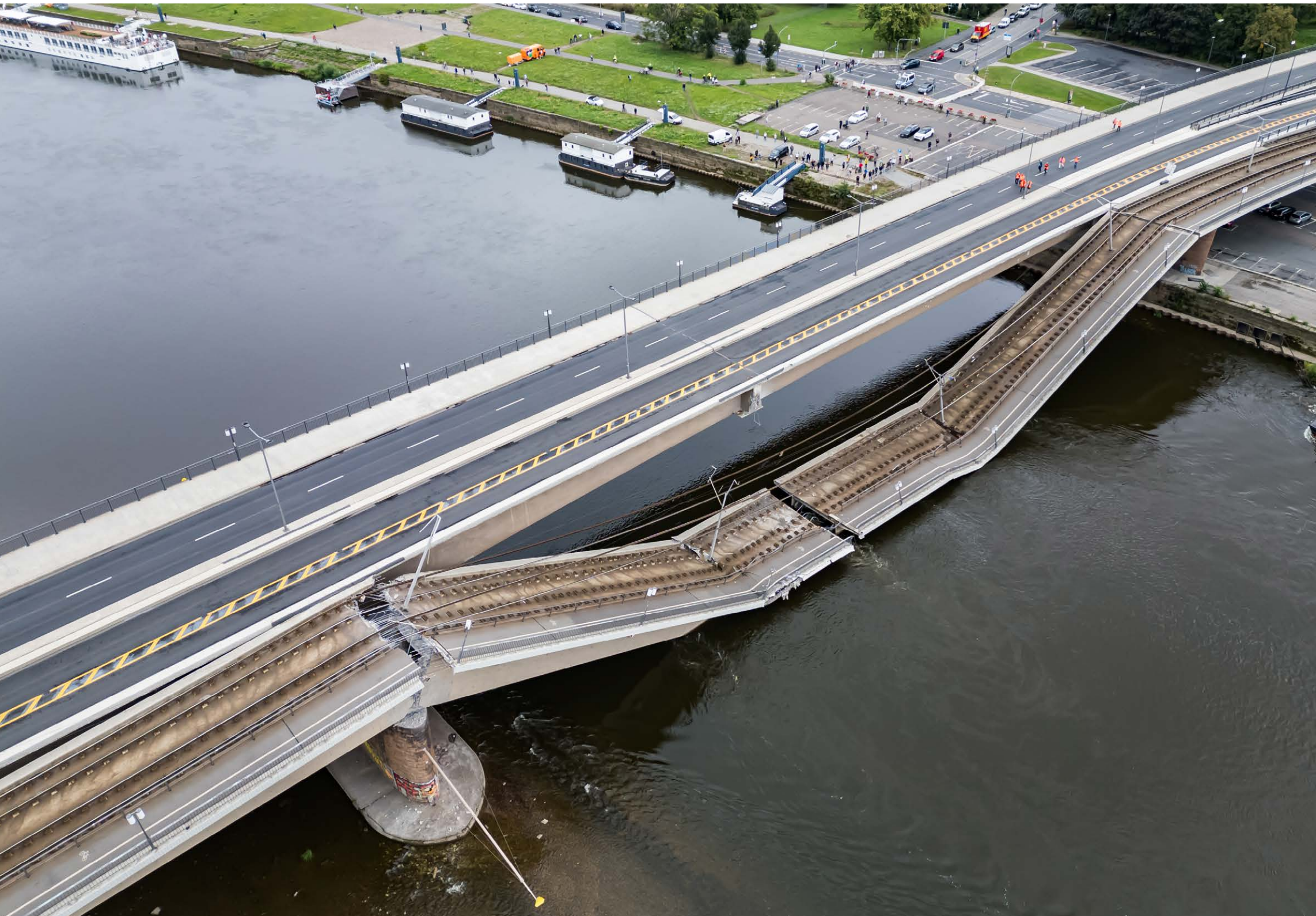
Drohnenfoto der eingestürzten Carolabrücke in Dresden. Die Spannbetonbrücke stammt noch aus DDR-Zeiten und wies strukturelle Defizite auf.
