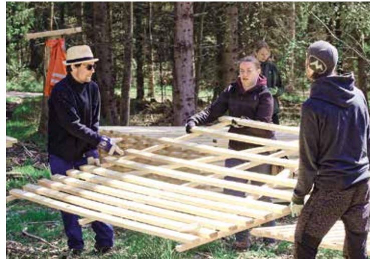
Bau von Hordengattern in Meiningen
