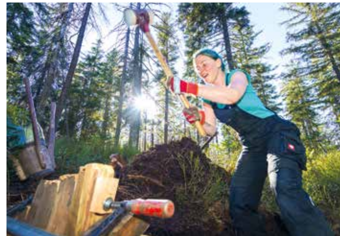
Eibenstock: Freiwillige beim Einschlagen von Grabensperren
