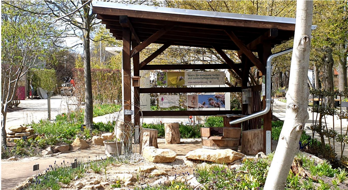
Pavillon mit Regensammeldach
