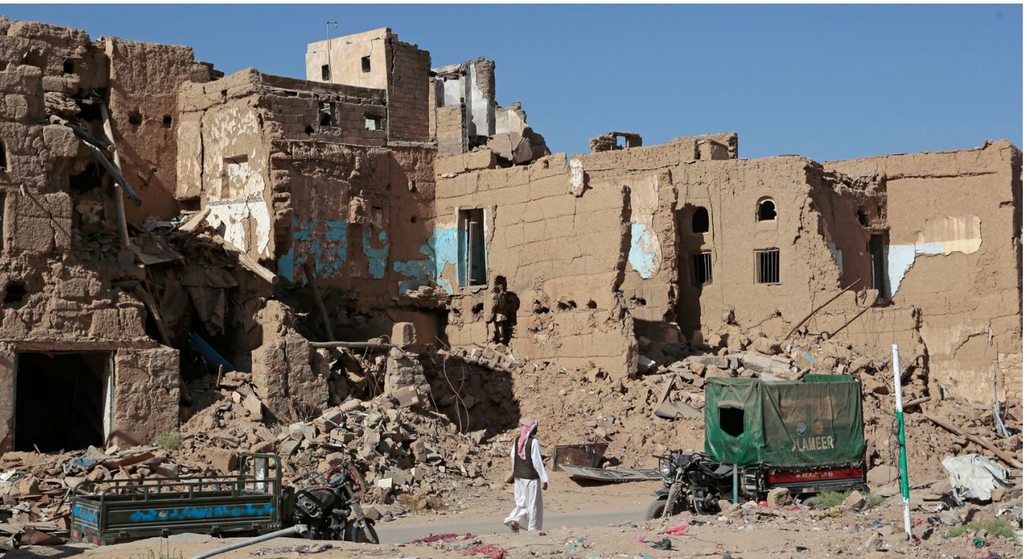
Wohnhäuser in Sa'da (Jemen), die durch Luftschläge der von Saudi-Arabien und Vereinigten Arabischen Emiraten geführten Militärallianz zerstört wurden. Durch diese völkerrechtswidrigen Angriffe sind mehr als 20.000 Zivilist:innen getötet und verstümmelt worden, darunter viele Kinder.
